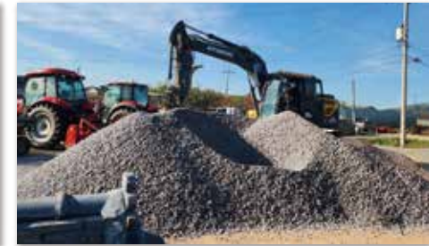
국내 최초 특수 배합장비를 개발, 도입하여 보다 정밀한 입도로 시공 품질 우수성 확보
