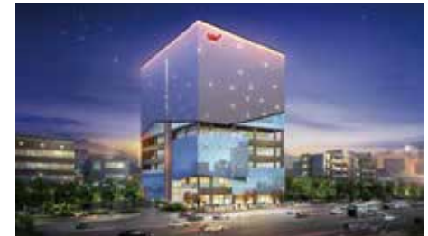
인천학익 CGV 신축공사(포스코이앤씨)
