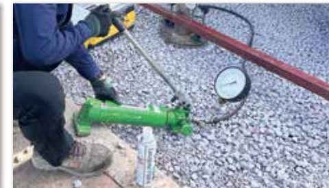
기초지반의 지지력 보강, 침하량 감소
